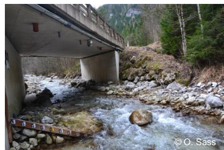
Abflusspegel an der Gsengbrücke im Johnsbachtal
